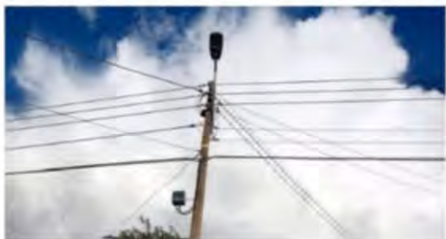
Figur 4: Nettselskapa brukar dei same lysmastene til å forsyne bustader og verksemdar med straum i nokre tilfelle (forkortinga NS står for Nettstasjon, dvs. transformator). Kjelde: Hordaland fylkeskommune, samferdselsavdelinga, vegseksjonen: Veglysanlegg i Hordaland i 2016.
